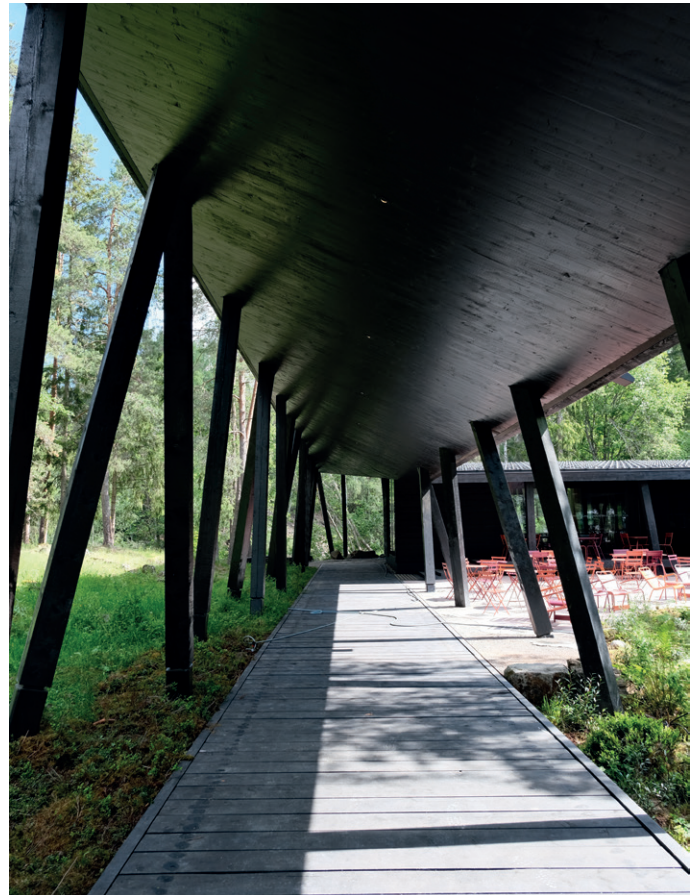
Bygget er formet med mange ulike vinkler som må møtes nøyaktig.
