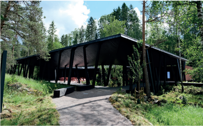
Bygget er i hovedsak oppført i tre, men toalettområdene er bygd med rød betong.
