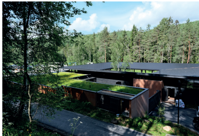
Bygget er 780 kvadratmeter.
